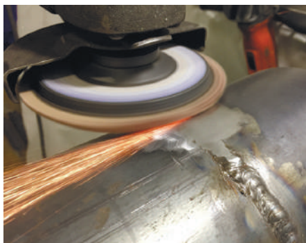
Зачистка сварных швов и обработка кромок
